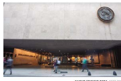
Nuevo edificio BCBA 1977-2017
